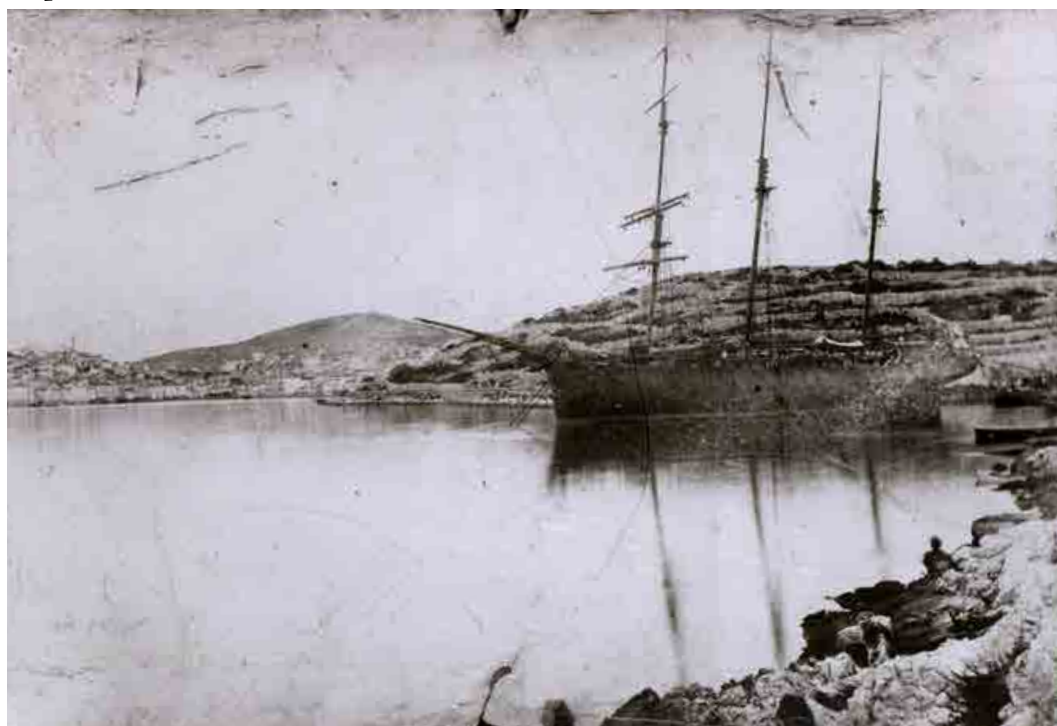
Istro appena costruito nel cantiere a Velopin (1889)
