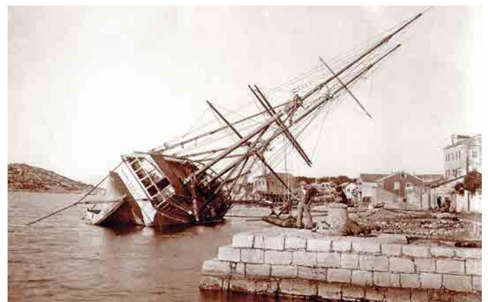
Calafatura di un veliero nel cantiere Martinolich. Fotografia datata tra 1895 e 1905
