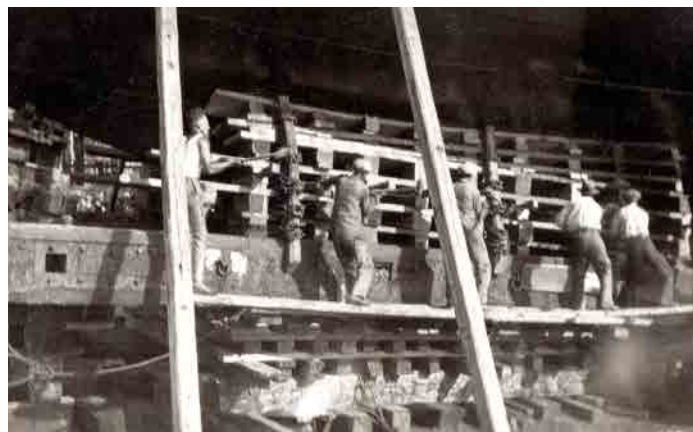
Gli operai del cantiere tolgono i cunei che bloccano l'imbarcazione sullo scalo immediatamente prima del varo
