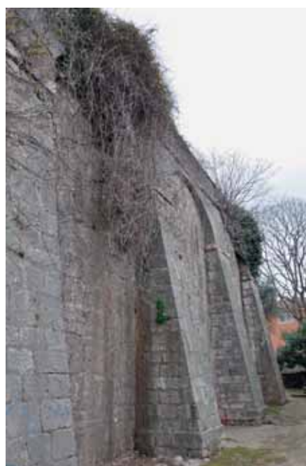
Il muro della cisterna - Foto Rita Giovannini
