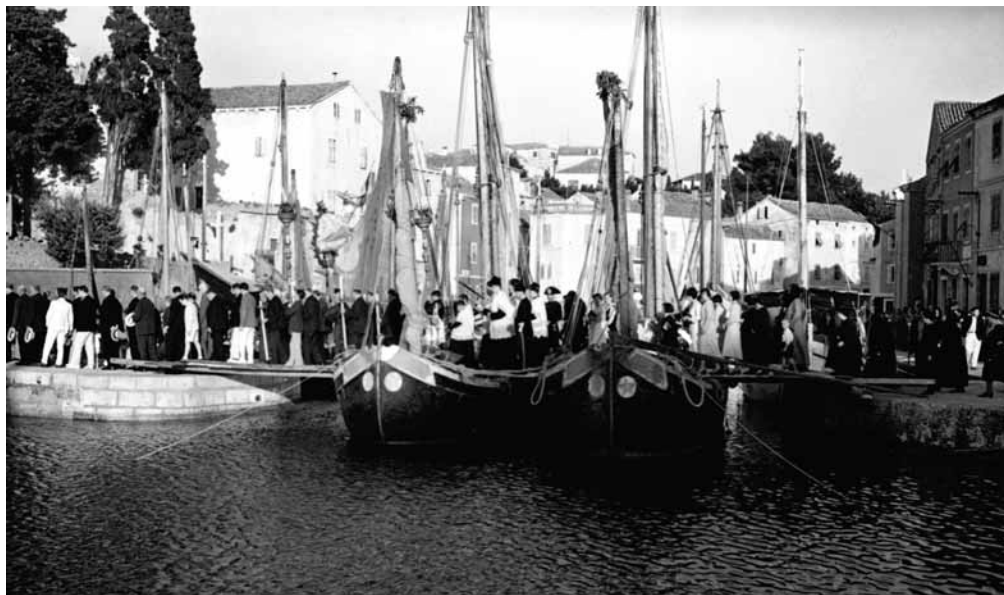
Nel ponte tra i bragozzi attraversano il mandracchio gli uomini...
