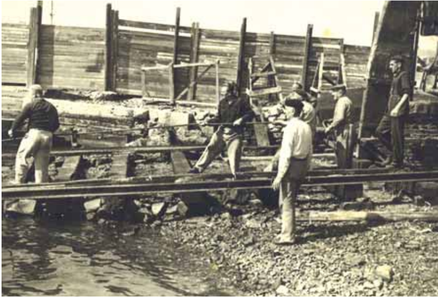
Marino Piccini in cantiere a Trieste
